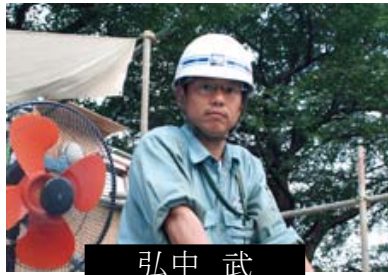
弘中 武 念願の基礎工事の 管理に打ち込む
