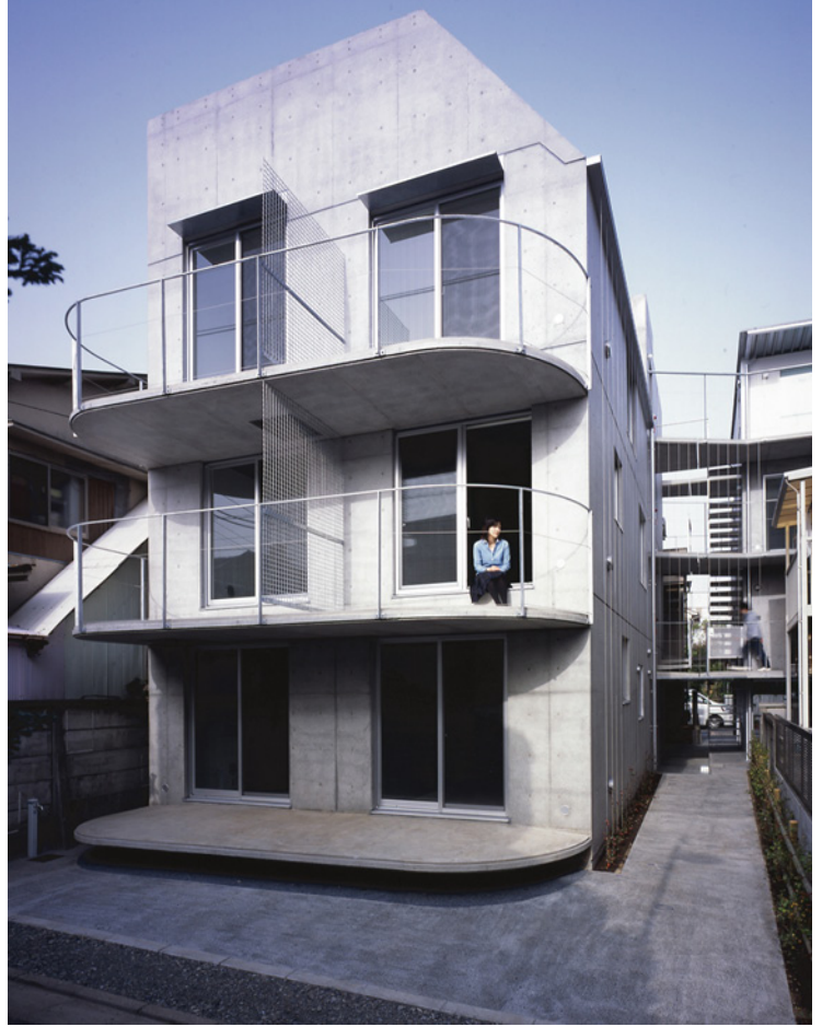
練馬集合住宅E棟 右側のW棟との間に路地を設けている。 撮影:新 良太
