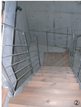
①全景 昼景:ファサードは軽快で開放的。②地下への階段はコンクリート打ち放しの壁に、ウレタンシルバー塗装の手摺。踏み板の木はレッドシダー。③ファサードはアルミのカーテンウォール。中はグリッド棚が付いている。
