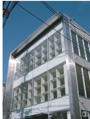
①全景 昼景:ファサードは軽快で開放的。②地下への階段はコンクリート打ち放しの壁に、ウレタンシルバー塗装の手摺。踏み板の木はレッドシダー。③ファサードはアルミのカーテンウォール。中はグリッド棚が付いている。
