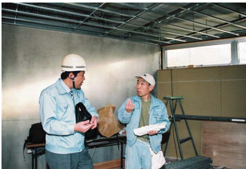
現在辰で施工中のT邸にて。今日の作業の確認をする大山専務と大工の大森さん。
