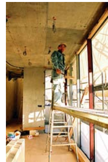
カーテンボックスを作成する大森さん。スペースを制限される現場では、十分な安全管理と手順が要求される。
