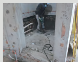
スラブ躯体解体作業中
