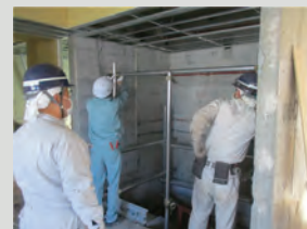
3階階段室。スラブを開口し新しく階段を設置
