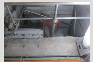
躯体補修後、螺旋階段を設置
