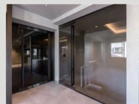
完成後。ガラスを設置し閉塞感をなくした
