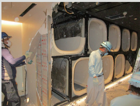
解体工事作業中
