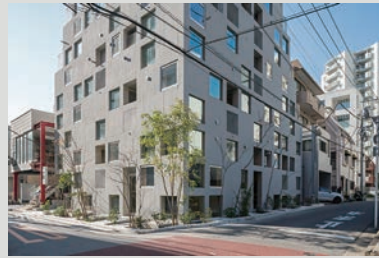
【はつせ三田】 構造：RC 造 規模：地下 1 階・地上 7 階 用途：共同住宅 設計：井原正揮・井原佳代／ihrmk 竣工：2019 年 12 月 撮影：稲継泰介
