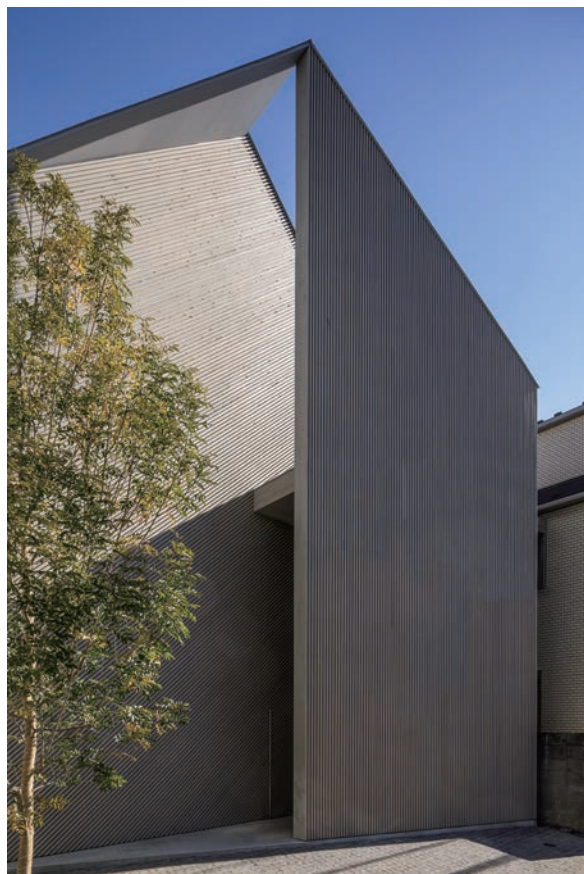
建物全景。断熱・遮音性を高めている
