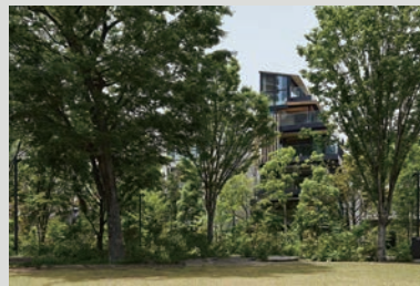
【裏参道テラス】 構造：S 造 規模：地上 6 階 用途：店舗・共用住宅（全 3 戸） 企画：ATOMIC 'S 設計：フジワラテッペイアーキテクツラボ 構造設計：小西泰孝建築構造設計 設備設計：森村設計 竣工：2021 年 3 月 撮影：©Nacasa & Partners Inc. FUTA Moriishi
