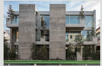
【TREES】 構造：RC 造 規模：地上 3 階 用途：共同住宅（全 11 戸） 企画：タカギプランニングオフィス 設計・監理：伊藤潤一+伊藤潤一建築都市設計事務所 構造設計：多田脩二構造設計事務所 竣工：2020 年 1 月 撮影：Satoshi Asakawa
