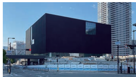
大阪中之島美術館外観 遠藤克彦建築研究所提供(2022年2月2日開館)
