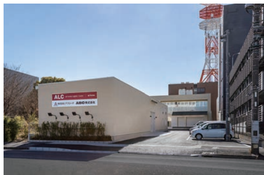
建物全景。倉庫等の看板がシンプルな外観のアクセントに
