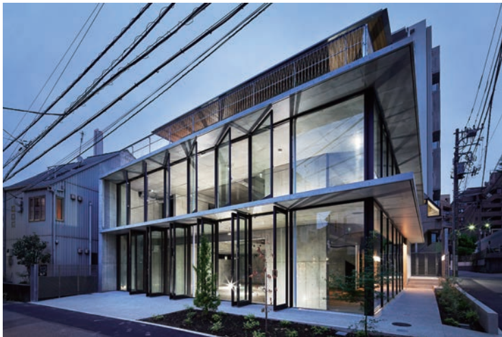
北西側全景（夕景）。周辺に開かれた軒下の通路。歩行者が通り抜けできる
