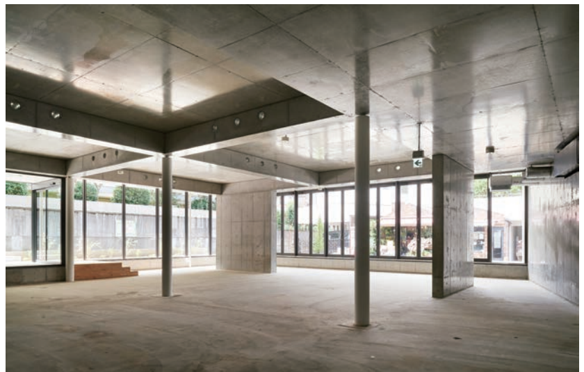
1階店舗スケルトン。耐力壁、柱の径、梁の配置で壁式構造でありながら開放的な内部空間
