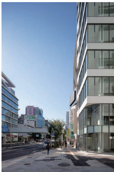
前面道路の国道 246 号線。渋谷方面を臨む
