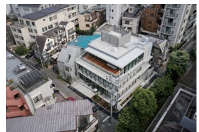
建物全景（ドローン撮影）
