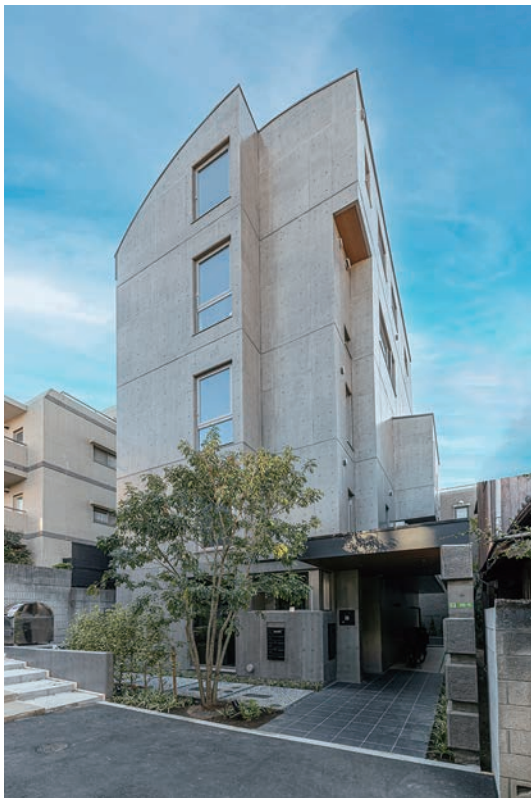
① 全景。傾斜のある前面道路。シンボルツリーが彩りを添える
