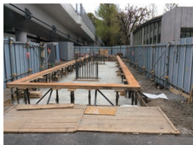
外壁を50cm浮かせるために設けられた台
