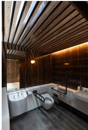
天井の木製ルーバーで換気と採光を得る
