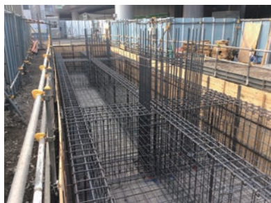
外壁を支える2本の柱の鉄筋が組まれていく
