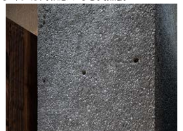
外壁を支える柱は850 x 1400 mm。ハードな洗い出しの質感が力強い
