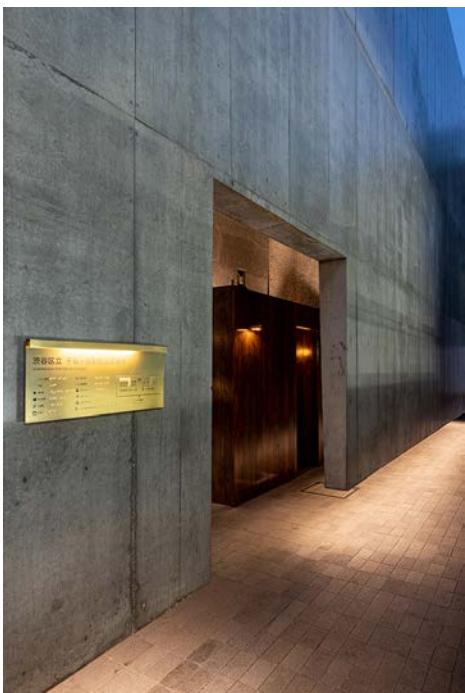
入口は一つ。コンクリート壁厚は180 mm
