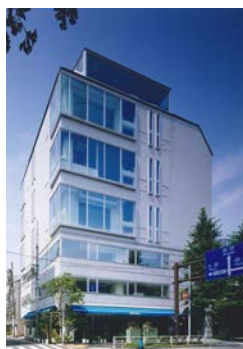
「Barbizon55(改修設計)」(2007) テナントビル
