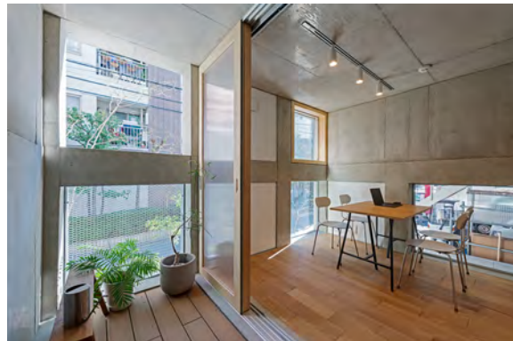
102 号室のインナーテラスと居室。内外双方に防火設備を設けている
