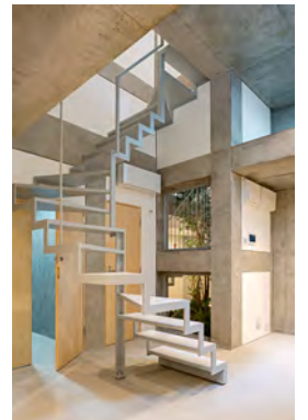
メゾネットの 102 号室の地下 1 階部は 1.5 層分の吹き抜け
