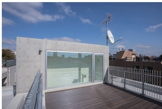
3階屋上デッキ
