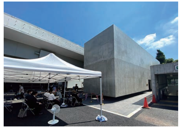
高さ7.5mの大きなコンクリートの塊が存在感を示す
