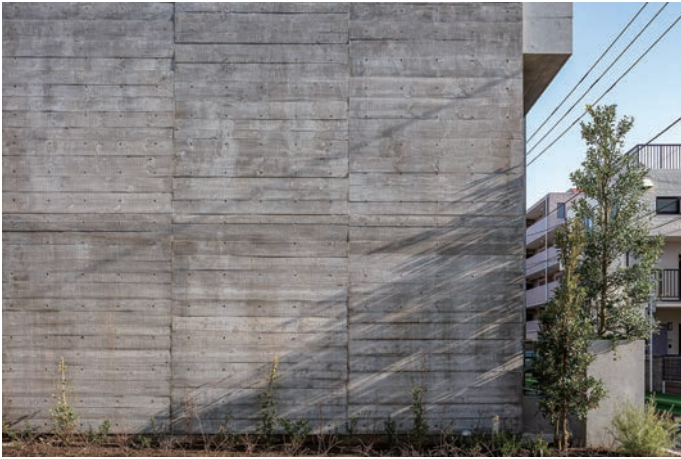
矢板を用いたコンクリート打ち放しの外壁
