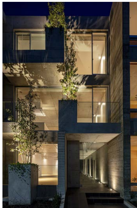
外壁や樹木がスポット照明で浮かび上がる
