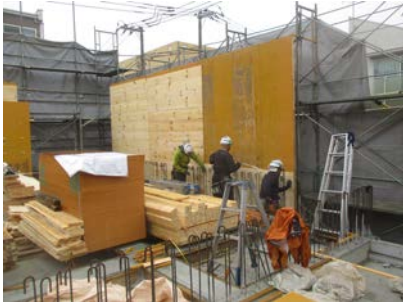
矢板施工中1：通常の型枠に矢板を貼り付けていく
