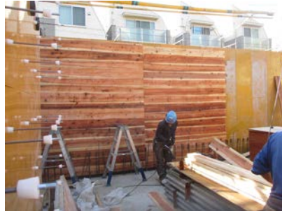
矢板施工中2：正面に見えるのが矢板の型枠
