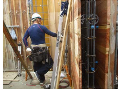
開放された型枠の戸口から矢板面が見える
