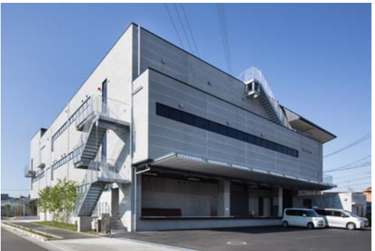
北側の配送ヤード。南側の道路を挟んで従業員の駐車場も確保
