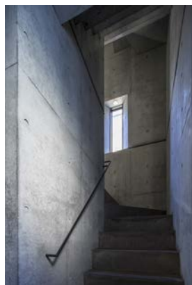
建物東側の階段
