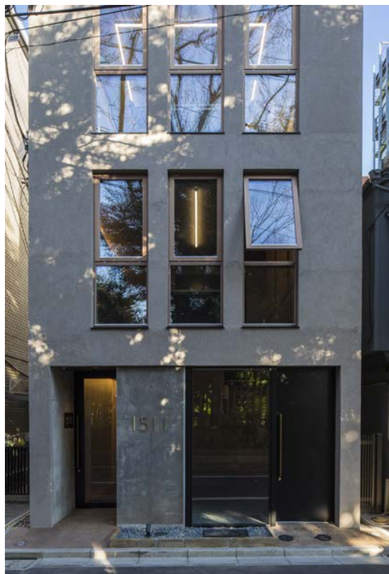
縦長の開口部が神宮外苑の銀杏並木の緑を映し出す。外壁は東邦レオの外断熱エコサームを採用
