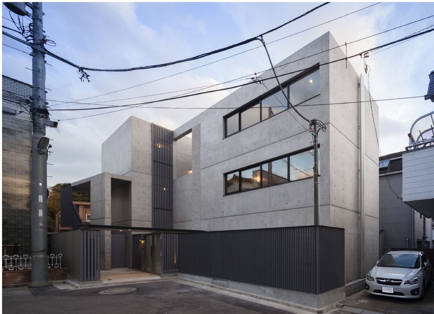
「東大井3丁目集合住宅」 撮影：小川重雄
