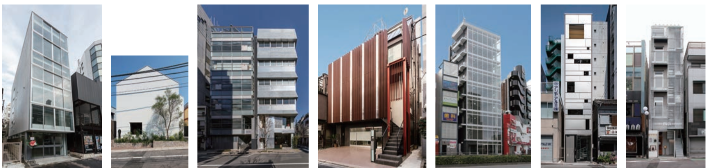
この 1 年半ほどの間に当社が施工した鉄骨造の建物群
