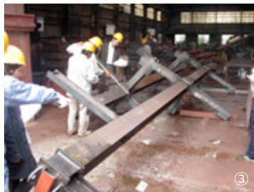
③鉄骨工場にて製品検査
