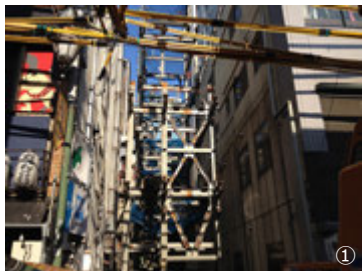
①2013 年秋、鉄骨建方状況
