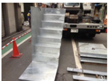
⑤鉄骨階段をパーツごとに分けて現場搬入。取付部は全てボルト止め
