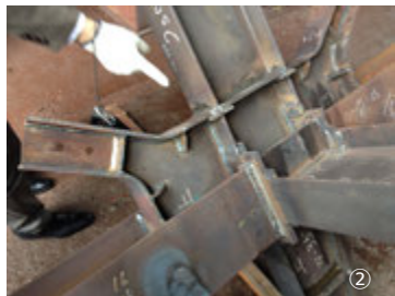
②鉄骨柱・梁・プレース接合部。通常の部材よりもリブを多く取り付けている
