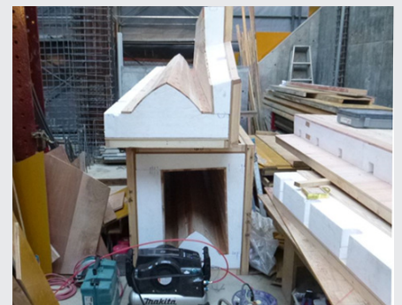
制作中の杉板とスチロールの型枠
