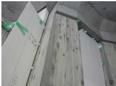
②図面を出したサッシの枠を、原寸大のスチロール枠を作って確認
