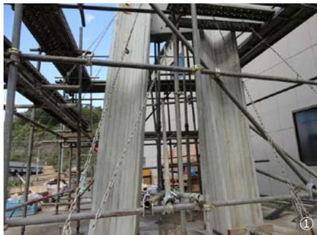
①鉄筋の加工場でモックアップ(試作品)を製作、実際にコンクリートを流して、そのカブリ、表情を確認する。
