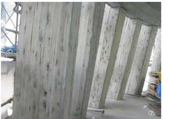
⑦2階型枠脱後後の柱の状況。斜めの傾きが全て異なる様子
