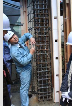
④4階の柱の鉄骨のジョイント部分。4階までは無垢の丸棒を溶接してジョイントにしているが、5階より上は仮設材で継ぐ
