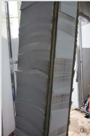
③1階の柱の特殊型枠のスチロールを削ったところ。杉板はまだ残っている
