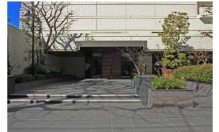
アプローチの床タイル貼替え、花壇の立上げ、笠木貼替え、入口を自動ドアに取替え、軒天に祭のちょうちん用コンセント設置
