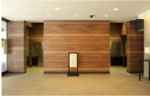
エントランスホールの床タイル貼替え、壁は石に貼替え、ポストコーナー入口壁はダイノック仕上げに
