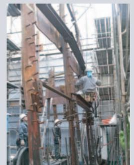
②工場製品検査の様子③1階部分の躯体イメージのCG④現場施工中の柱の様子。地下1階のコンクリート打設が終わったところ。この柱に鉄筋を巻きつけて、コンクリートを打っていく⑤2階部分の鉄骨組立
