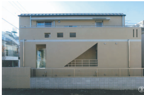
①全景夜景。2階のテナントは以前も入居していたジュエリーデザインの会社が入ることになっている②2階オーナー邸寝室。一番高いところの天井高は3.5m。収納も多めに取っている③北側全景。有機的な素材で構成されている
