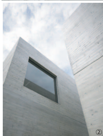
①斜めに傾いている建物の形状が道行く人の目を捉える②杉板型枠のコンクリート打ち放しの外壁。ガラスファサードのように店舗内部がすべて見えなくても、ポイントとなるコーナーが見えればいい③2棟の間の階段が双方の建物の地階へのアクセスとなる④1階入口⑤1, 2階店舗の内部
