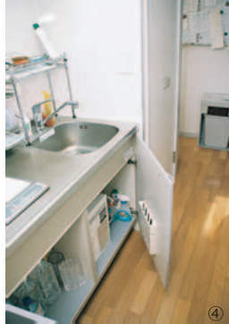
①手すりなどの再塗装を行った(写真は竣工時)②建物のはるか南側に聳え立つケヤキの木(写真は竣工当時)季節を楽しませてくれるが、秋には落ち葉が建物前まで落ちてくるため、掃除はこまめに行う③エントランスも再塗装を施す④1階事務所台所。シンク下の床板のベニヤが薄く、モノを置くこととたむむため、金属版を貼った。「メーカーは標準仕様ということだが、洗剤などの置き場所になるため、もっと荷重に耐えられるものをと要求した」(関氏)⑤外壁のコンクリートなどの問題はほとんどなかった
