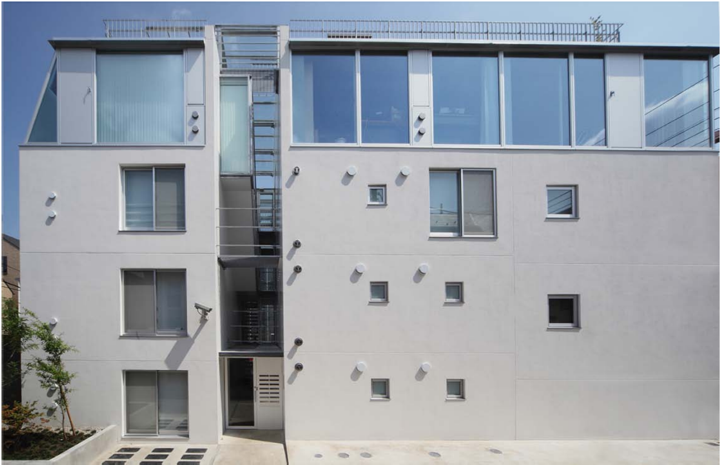
【集合住宅SK】南西側壁面 撮影：アック東京
