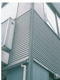
①エントランスの砂利仕様の床のはがれと、壁。壁の下部には新たに金属プレートを貼っている②屋上塔屋。向かって左側の壁に穴を開けられたため、修復して全体に再塗装。エアコンの室外機③4階のメイド居酒屋。シンプルな空間④屋上のガラスファサード。写真ではわかりにくい鉄枠の角が少し錆が始めている⑤1階から2階にかけて外壁にガルバリウム鋼板が貼られているが、アングル部分が鉄のため、錆が少し浮いている。
