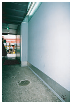
①エントランスの砂利仕様の床のはがれと、壁。壁の下部には新たに金属プレートを貼っている②屋上塔屋。向かって左側の壁に穴を開けられたため、修復して全体に再塗装。エアコンの室外機③4階のメイド居酒屋。シンプルな空間④屋上のガラスファサード。写真ではわかりにくい鉄枠の角が少し錆が始めている⑤1階から2階にかけて外壁にガルバリウム鋼板が貼られているが、アングル部分が鉄のため、錆が少し浮いている。
