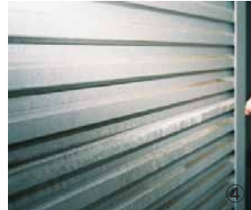
①1階建物裏側②東側外階段の連結送水管ボックス。赤錆が垂れている③外階段から南側を臨む。かなりの高さのため、外灯の塗装や外壁掃除は業者が足場を要求する④外壁ガルバリウム鋼板に付いている白い汚れ⑤エントランスと植栽のオリーブ
