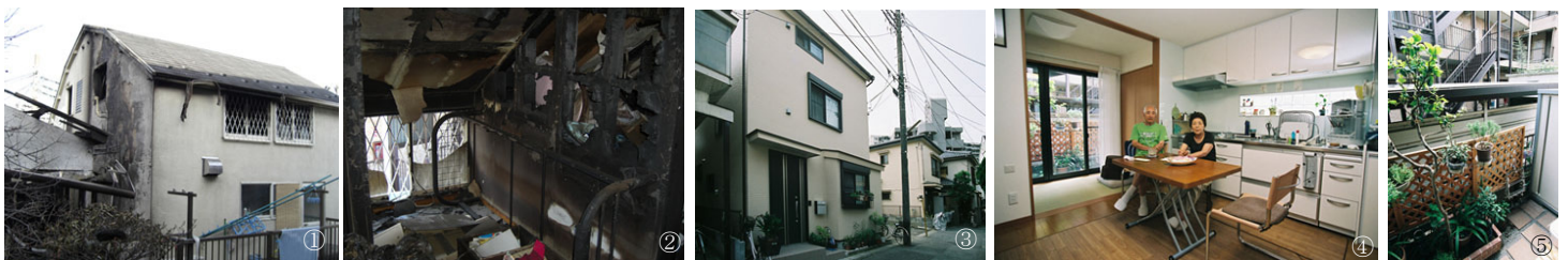
①南東側からみた火災直後のK様宅。左側が火元の家②3階。外壁は残っていますが内部はこの通り③北西側からみた新しいK様宅④1階リビングダイニングでくつろぐK様夫妻⑤最近の豪雨を鑑み、K様宅に雨水が流れ込まないよう、隣接するマンションの自転車置き場の屋根に樋を新たに設置させてもらった
