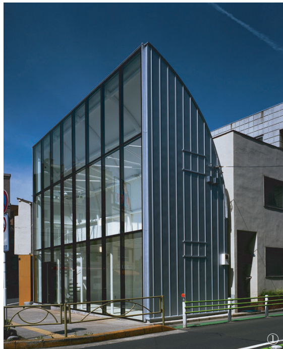
①南側全景。建物の形は写真手前に向かって、約1m開いている。軒の高さを一定にするため、弧状の鉄骨トラスは見た目より複雑な鉄骨構造となっている②建物正面。分割された、ファサードの上部にスクリーンが張られる。現在は、シャンパン・カフェが入ることが決まっている③設計段階での展開イメージの一つ。ラッピング・アーキテクチャー
