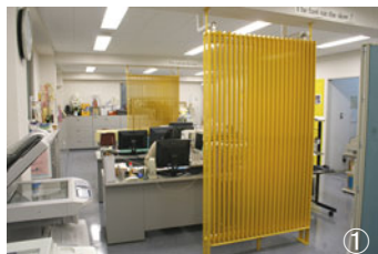
①1階オフィス。幅射式冷暖房機器PSは仕切りと冷暖房の空調の役目を果たしている②3階教室。小さな子供たちが触れても安心③3階のそろばん博物館。見学には予約が必要④1階トイレ。もともとの計画では、洋式トイレは個室になっていたが、スペース確保のために壁をはずした。
